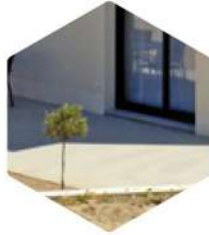
• Terrasse en béton poreux
