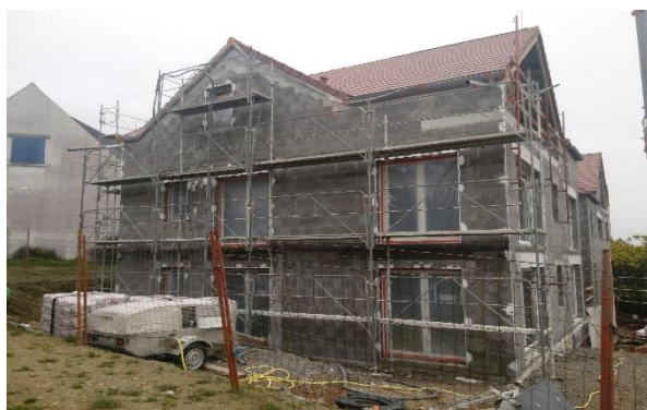
Echafaudage de l'enduseur en place
