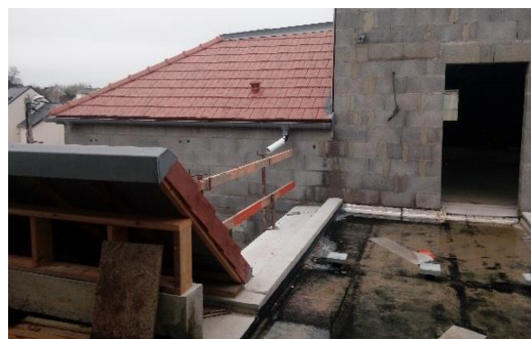
Couverture en tuiles réalisée.
