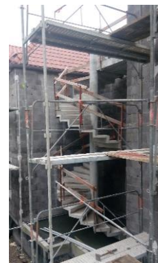
Vue de l'escalier extérieur en béton.
