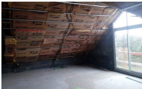
Isolation sous toiture terminée.
