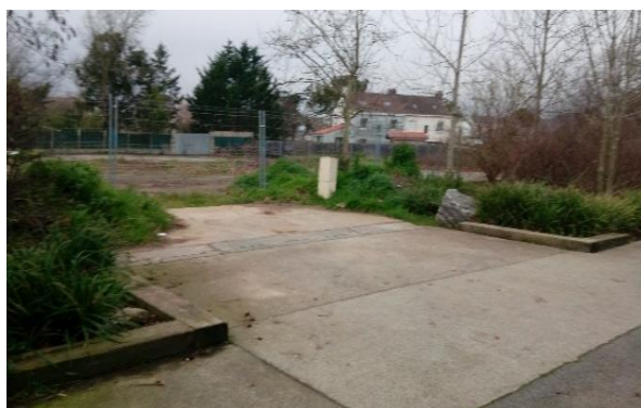
Accès au chantier depuis la rue des Frênes
