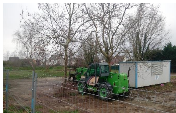
Installation de chantier en cours.
