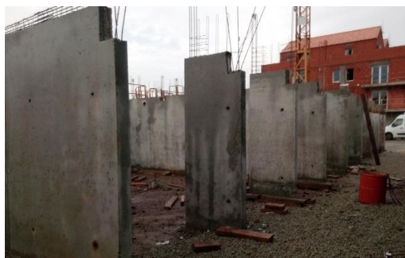
Vue de l'entrée des stationnements.
