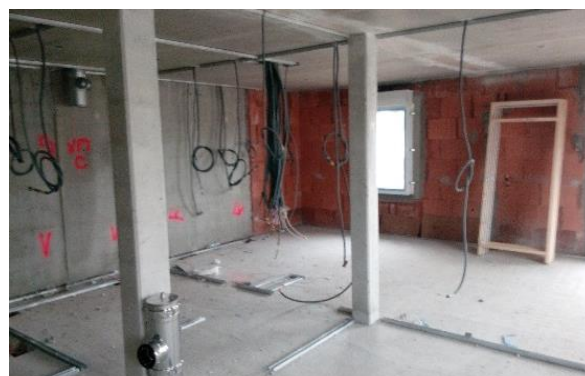
Cloisonnement en cours
