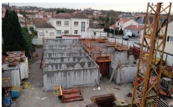
Elévations du Rdc terminées.
