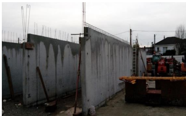
Préparation du plancher haut du Rdc.
