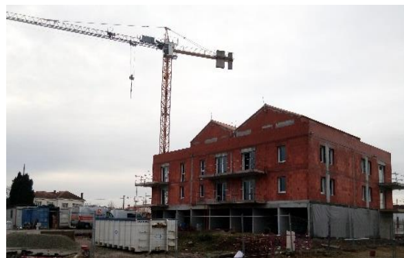
Clos- couvert réalisé.
