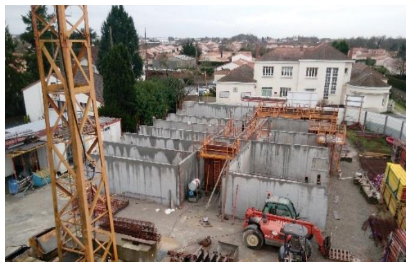
Vue depuis le bâtiment.B
