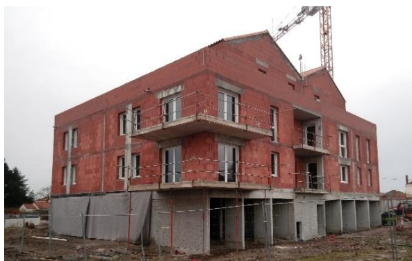
Façade R+1 des logts B101-B105-B106.
