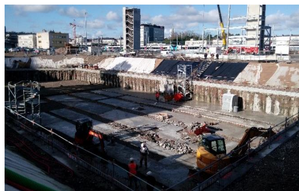
Sous-sol -2 en cours de réalisation.
