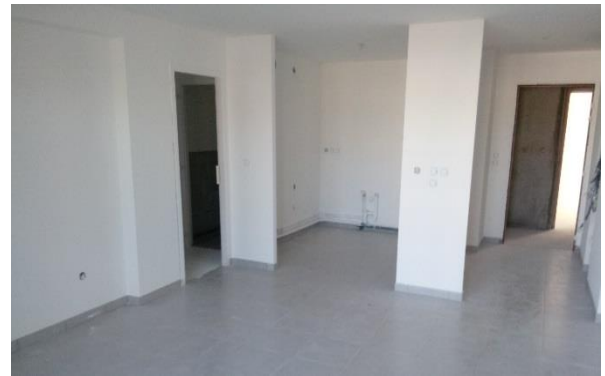
Peinture et revêtements de sols jusqu'au R+2
