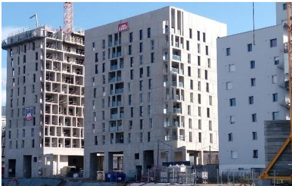
Vue de l'ensemble du bâtiment A
