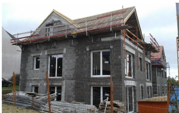
Réalisation de la couverture en cours.
