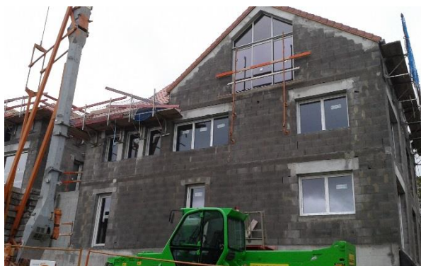
Vue vers la façade principale
