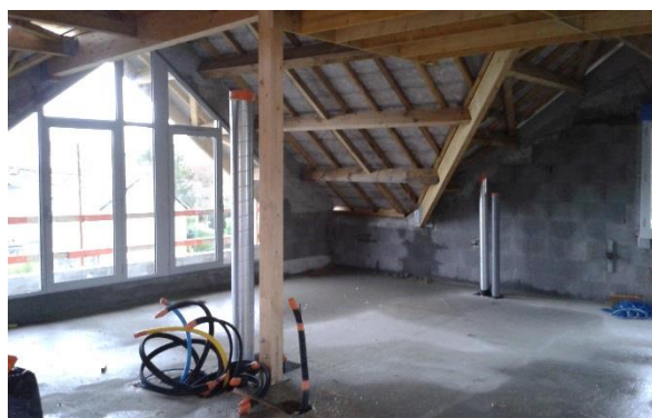
Menuiseries posées et charpente réalisée.
