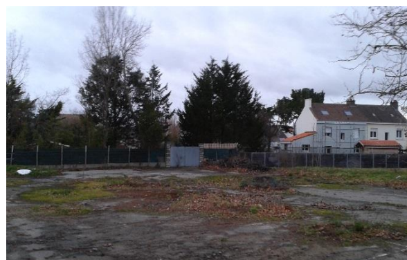
Nettoyage du terrain réalisé.
