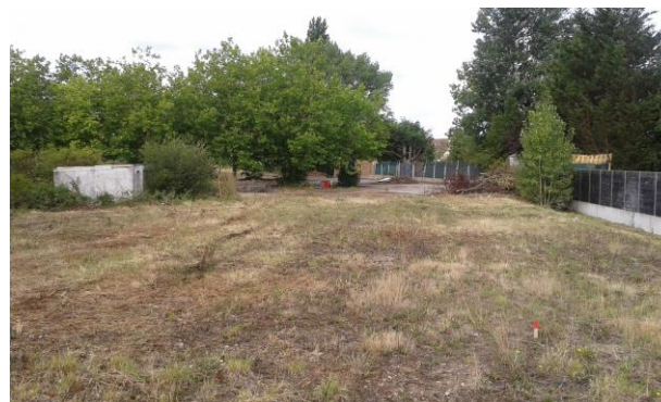
Nettoyage du terrain réalisé (2).
