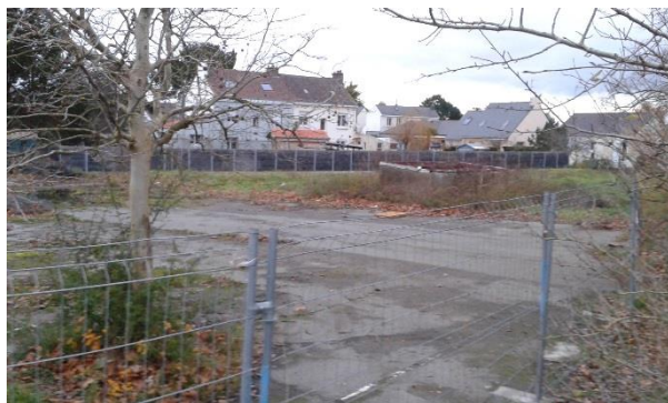
Barrières de chantier en place.
