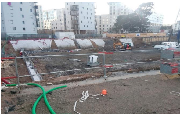
1 er Soubassement béton réalisé.
