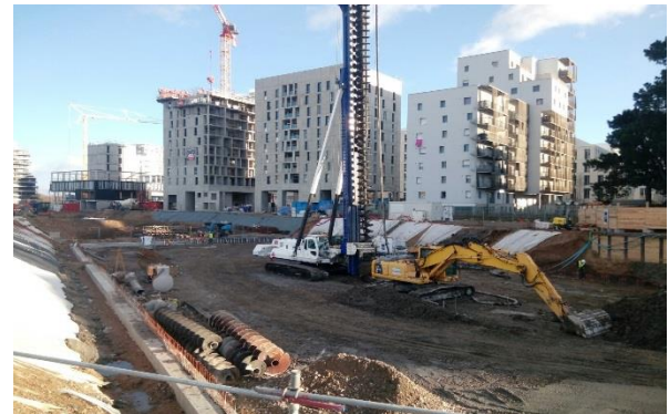
Terrassement et micro-pieux en cours.
