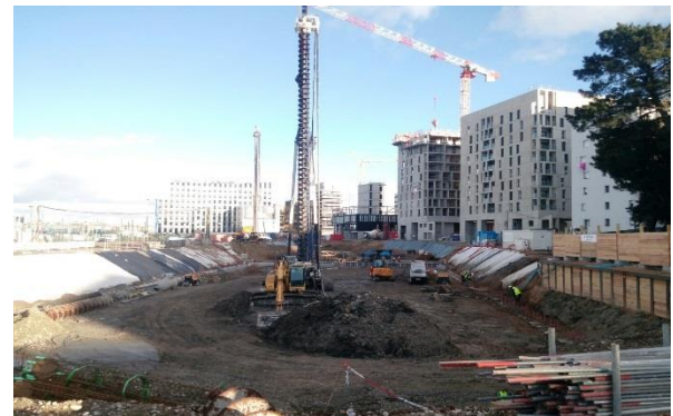
Vue depuis l'accès chantier.
