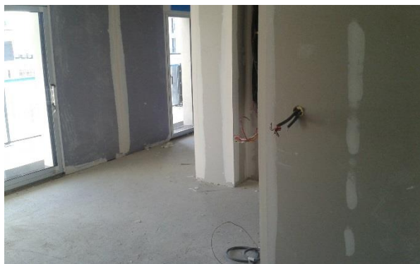
Doublages et cloisons réalisés jusqu'au 5e et.
