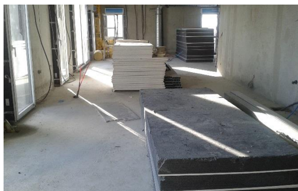
Menui. Ext. posées + appro. doublages au 9 e étage.
