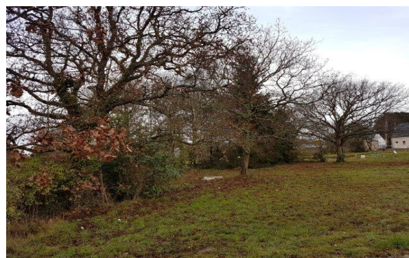
Nettoyage du terrain réalisé.
