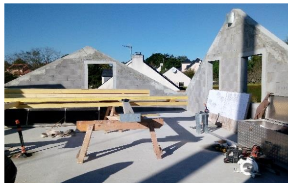
Achèvement du Gros-Oeuvre.
