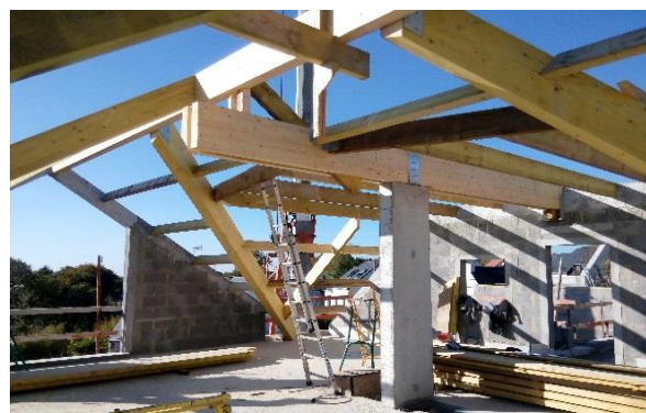
Charpente en cours.
