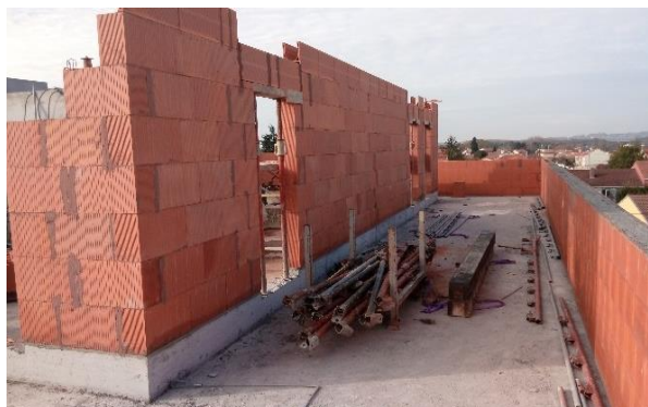
Dernier niveau de maçonnerie en cours.(Bât.B)
