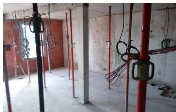
Démarrage du 2 nd Œuvre.
