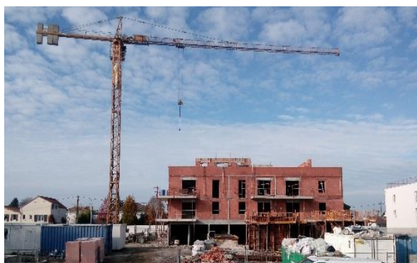
Vue depuis l'entrée du chantier.
