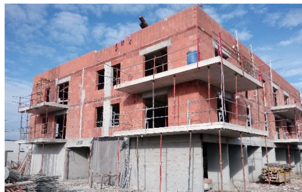
Vue depuis le RDC.
