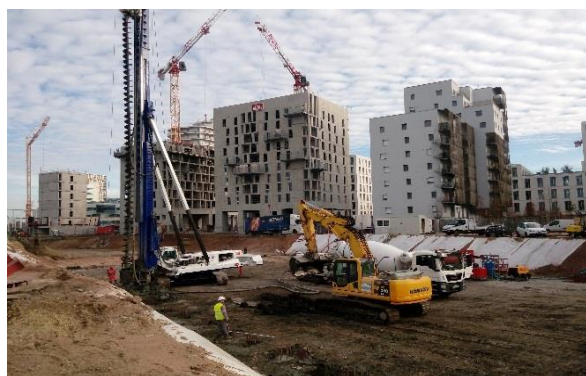
Fondations profondes en cours.
