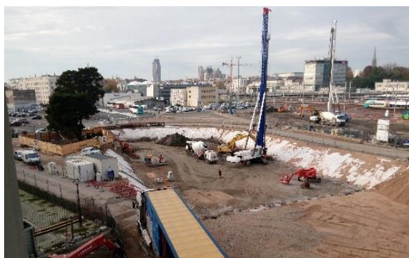
Démarrage des travaux.
