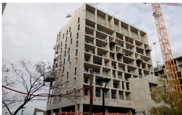
Elévation de la maçonnerie terminée
