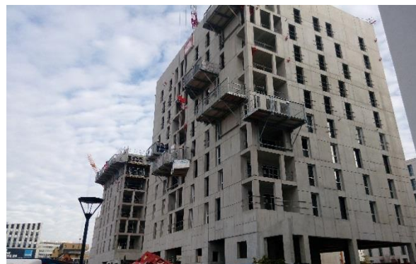
Pose des ouvertures au R+5 et R+6 en cours.
