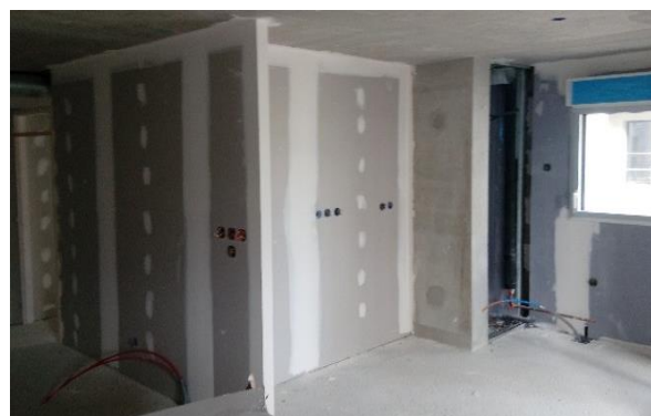
Cloisons et bandes placo réalisées jusqu'au R+2.
