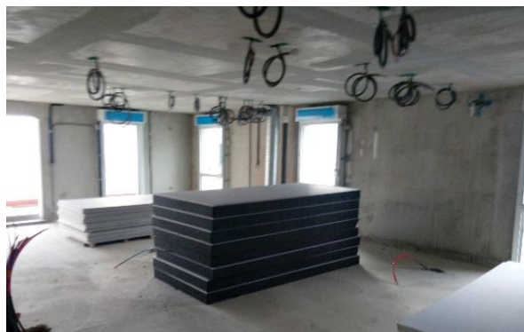
Doublages au R+5 en cours.
