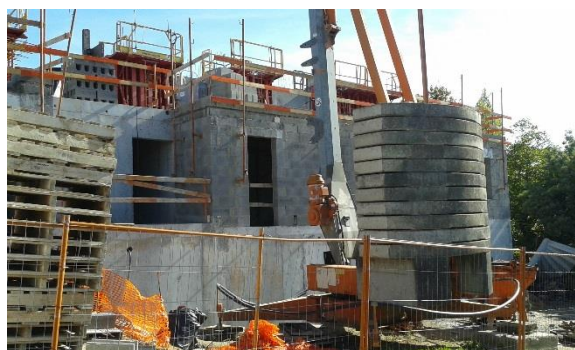
Elévations R+1 en cours.
