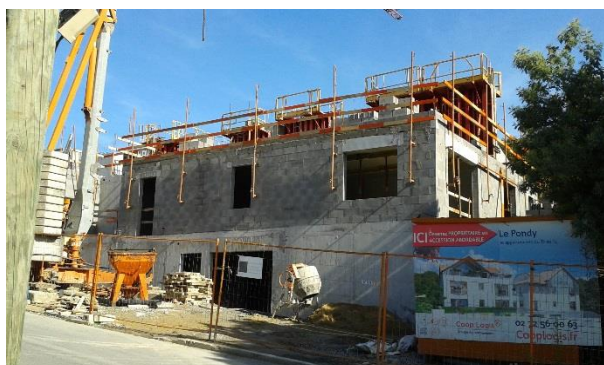
Plancher bas du R+1, réalisé.
