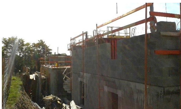
Vue du chantier depuis le Nord-Est.
