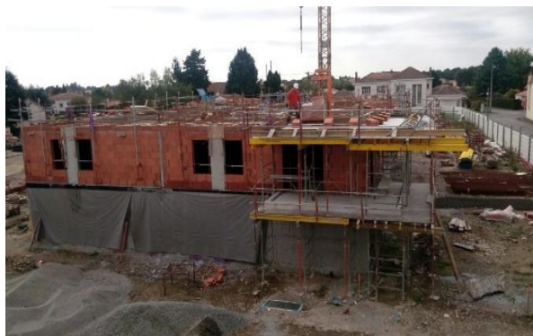
Mise en place du plancher R+2 (Bât. B)
