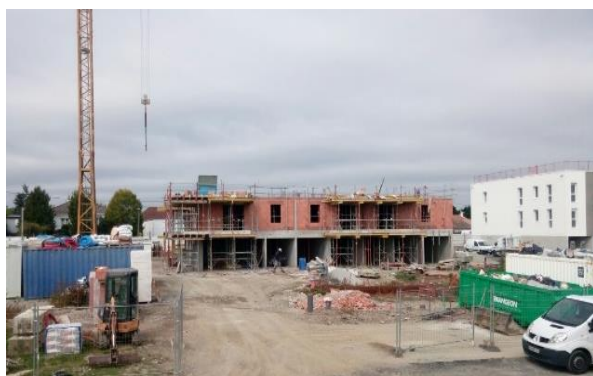
Vue depuis l'entrée du chantier.
