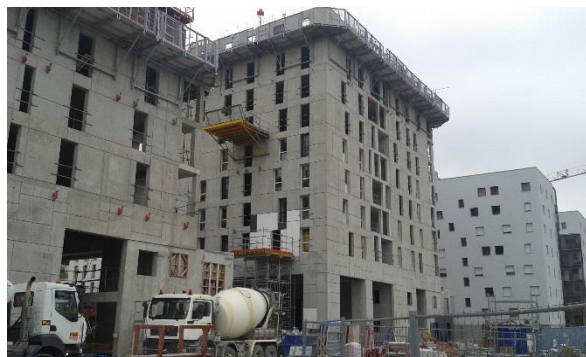
Vue depuis l'accès chantier
