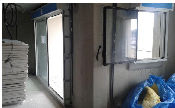
Pose des menuiseries ext. jusqu'au R+4.
