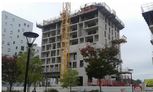
R+8 en cours
