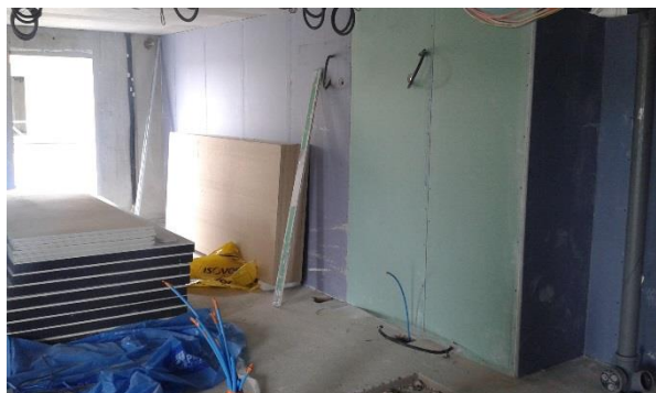
Doublages et cloisons jusqu'au R+2 en cours.
