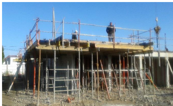
Coffrage du plancher R+1.
