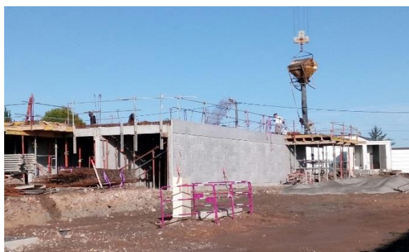
Elévations RDC réalisées.
