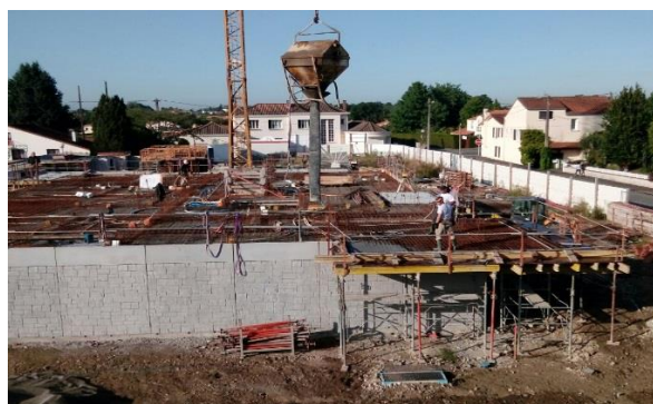
Coulage du plancher R+1 en cours.
