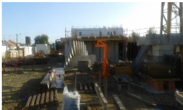
Stockage des éléments préfabriqués
