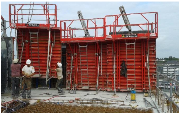
Elévations du R+7 en cours
