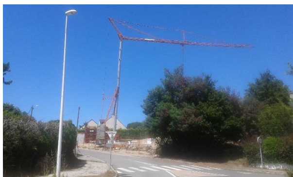
Mise en place de la grue
