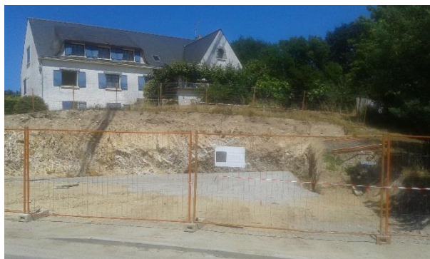
Plateforme sous-sol exécutée
