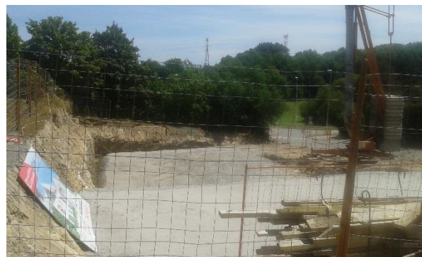
Installation de chantier effectuée
