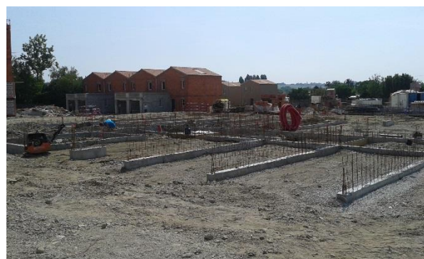
Fondations en cours
