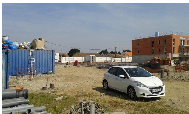
Vue à l'entrée du chantier
