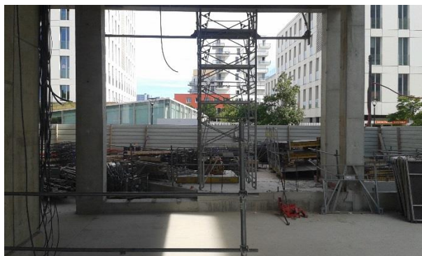
Plancher haut du 2 nd étage en cours
