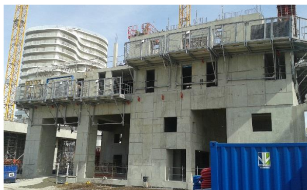
1 er Etage réalisé – Gros Oeuvre
