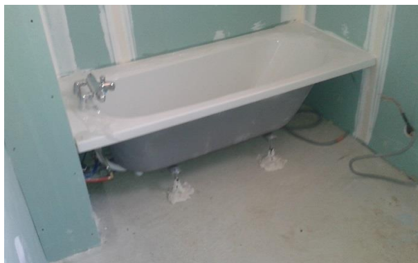
Equipements en cours
