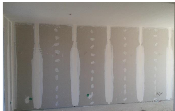
Finition placo en cours
